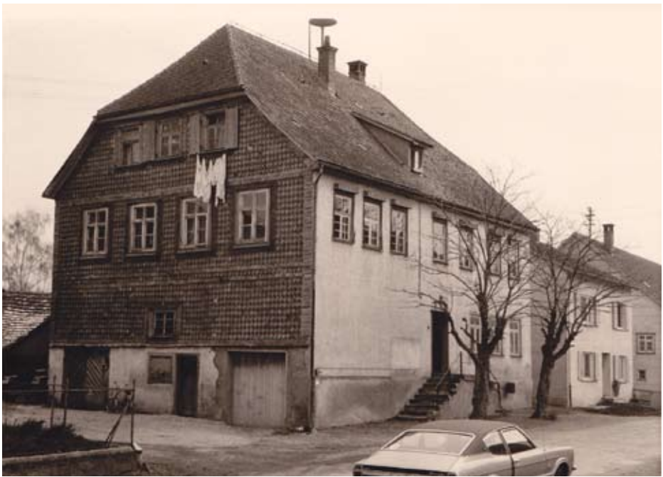
Rat- und Schulhaus in Oberböbingen
